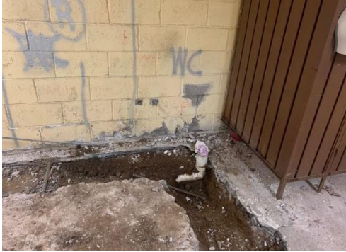
Figura 1. Retiro de instalación sanitaria. Fuente: Imagen propia.
