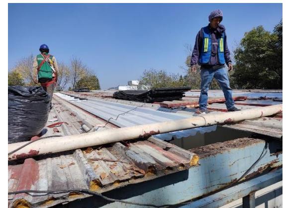
Figura 14. Cambio de láminas de policarbonato. Fuente: Imagen propia.
