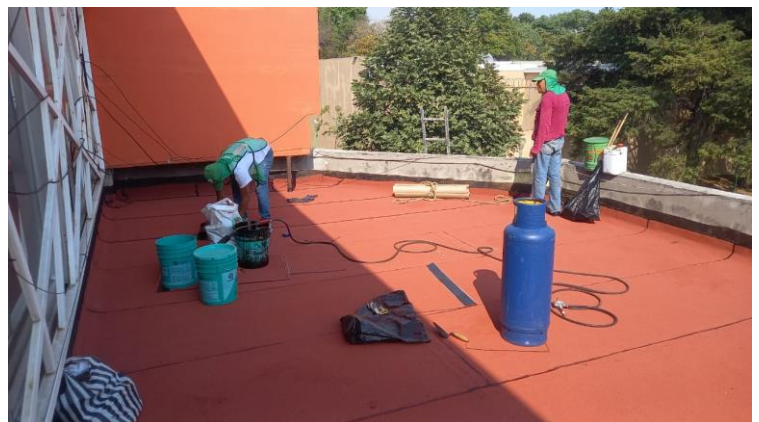
Figura 18. Impermeabilización en azotea de alberca Culhuacanes. Fuente: Imagen propia.
