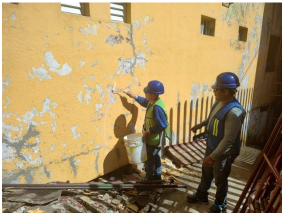
Figura 11. Desbaste de pintura anterior. Fuente: Imagen propia.
