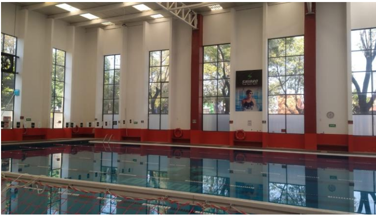
Figura 9. Antes de la rehabilitación. Fuente: Imagen propia.
