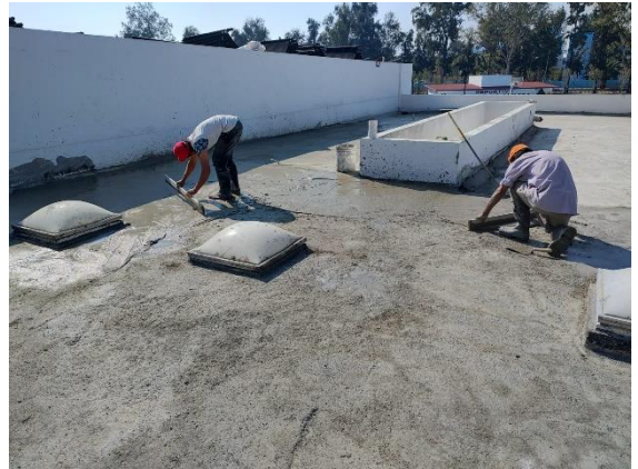
Figura 16. Colado de losa en alberca Corbalá. Fuente: Imagen propia.
