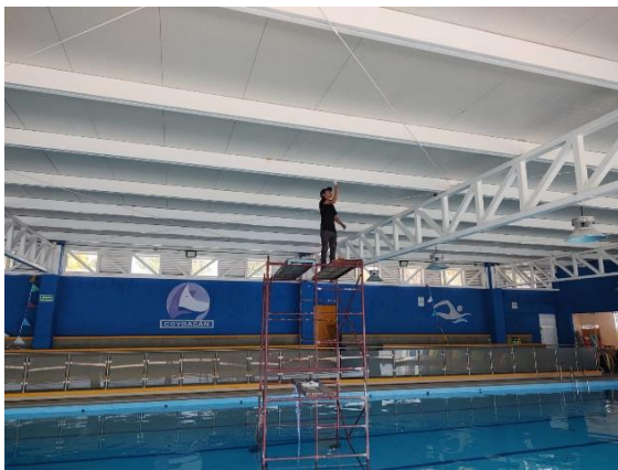
Figura 17. Pintura en estructura en alberca Corbalá. Fuente: Imagen propia.
