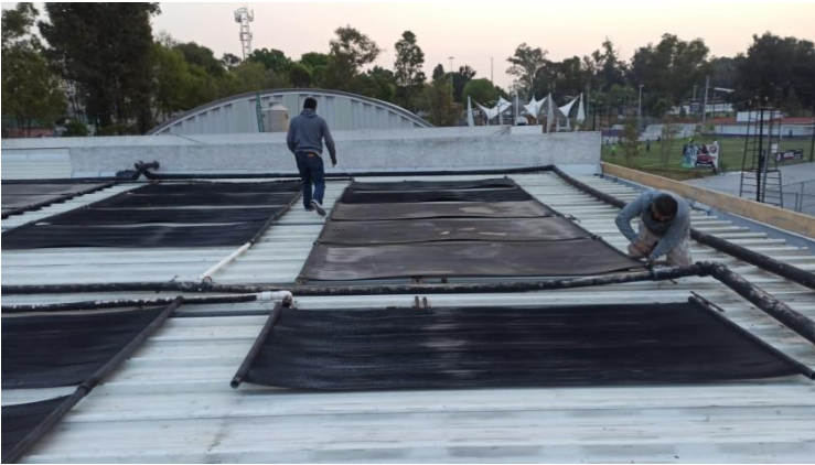
Figura 15. Desmontaje de paneles solares en alberca Corbalá. Fuente: Imagen propia.
