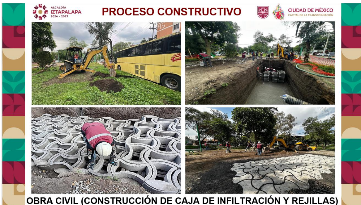
Figura 16. Presentación de construcción de pozo de absorción de SISTEMA PAICRET. Fuente: Elaboración propia, perteneciente a Subdirección de control y evaluación, Alcaldía Iztapalapa, Dirección General de Servicios Urbanos, 2025.
