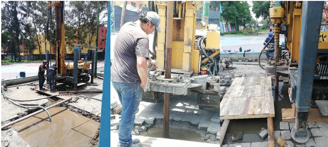
Figura 14. Supervisión de perforación para trabajos en pozos de absorción. Fuente: Elaboración propia, 2025.
