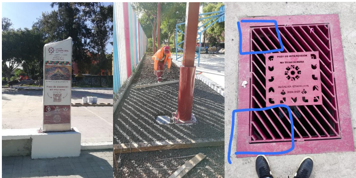
Figura 15. Supervisión para colocación de mobiliario y chequeo de trabajos de imagen urbana, para trabajos en pozos de absorción. Fuente: Elaboración propia, 2025.
