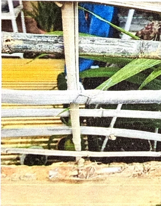
IMAGEN 15 – Reforzamiento de nodos estructurales. Colocación de tensores de alambre en las uniones de bambú para rigidizar el sistema portante antes de recibir cargas.
