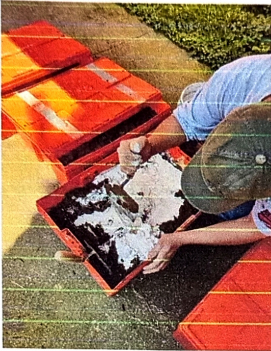
IMAGEN 13 – Estabilización de la mezcla. Integración de cal al adobe para incrementar su resistencia mecánica y su comportamiento frente a la humedad.
