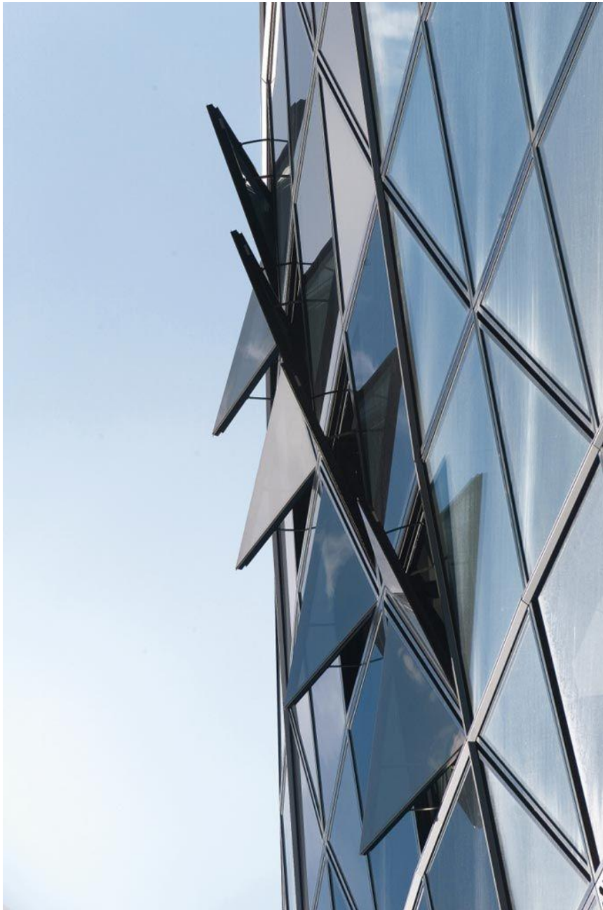
Paneles en fachada
