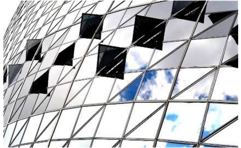
Abertura de paneles en fachada
