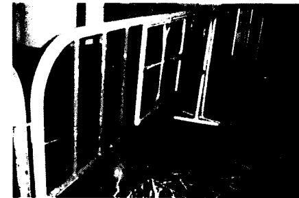
Vallas tubulares para impedir el paso en los pasillos de la estación Pino Suárez
