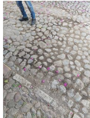
9. RESULTADO FINAL DE LA COLOCACIÓN DE PIEDRA BOLA EN CALLEJÓN TLAPANCALCO
