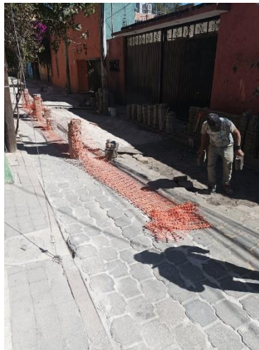
2. RECOLOCACIÓN DE ADOQUINES EN CARRIO SAN LUCAS, CENTRO DE COYOACÁN.
