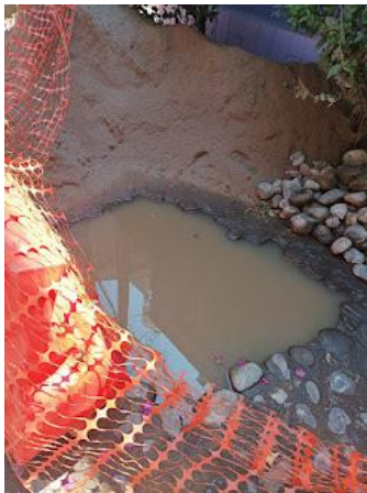
7. PRUEBA DE CAPTACIÓN PLUVIAL A CIELO ABIERTO EN CALLEJÓN TLAPANCALCO
