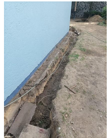
3. EXCAVACIÓN PARA INSTALACIÓN DE RED HIDRÁULICA EN VILLA PANAMERICANA
