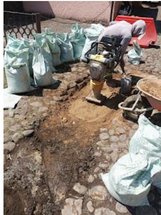
8. COMPACTACIÓN DE TEPETATE EN CALLEJÓN TLAPANCALCO
