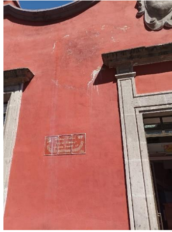
5. MUESTRAS DE SALITRE EN FACHADA PRINCIPAL DE LA CASA DE CORTÉS
