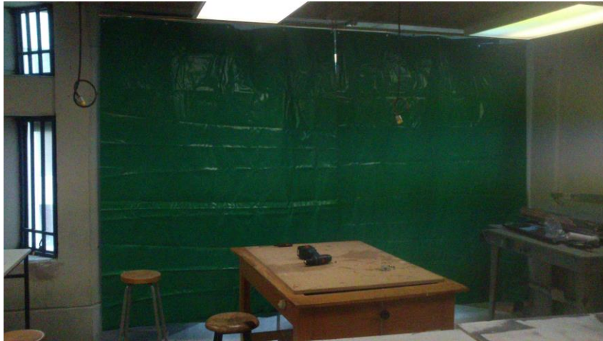
La cortina vinílica instalada en el área de la cabina.
