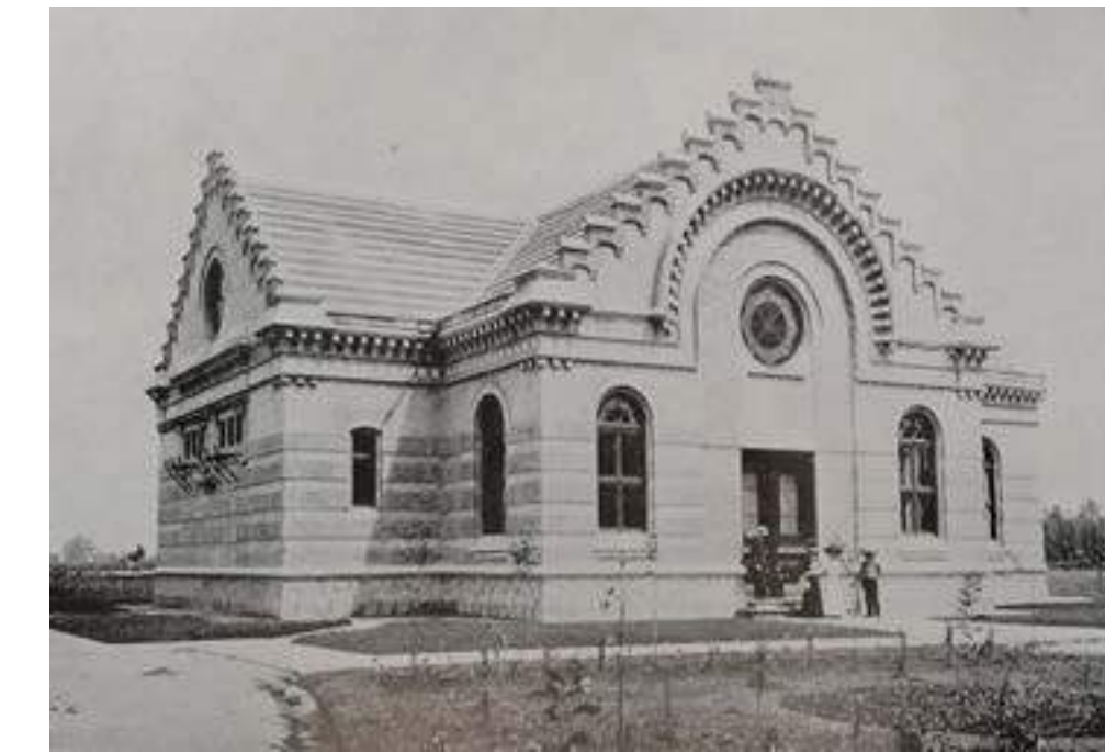
Imagen #23. Casa de Bombas #3 - Proyecto original. Fuente: Memoria descriptiva de las obras de provisión de aguas potables para la Ciudad de México.
