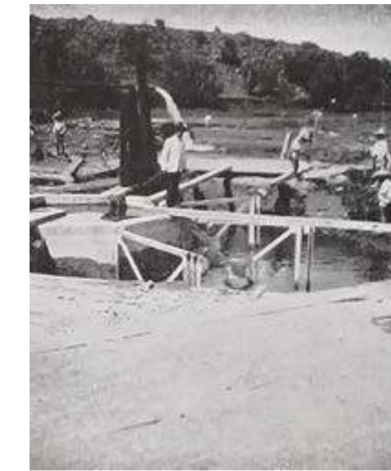
Imagen #25. Excavaciones de foso de captación del inmueble. Fuente: Fototeca Nacional
