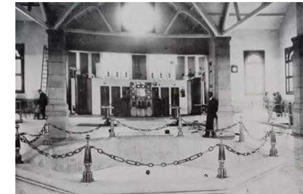
Imagen #27. Interior de casa de Bombas #3-Proyecto original. Fuente: Memoria descriptiva de las obras de provisión de aguas potables para la Ciudad de México.
