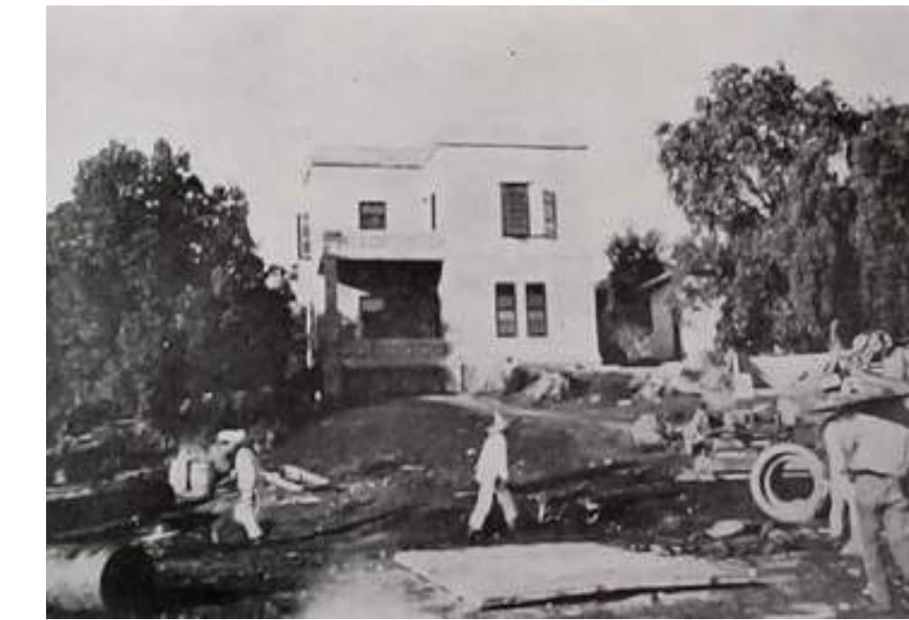
Imagen #24. Trabajadores locales iniciando obras de la Casa de Bombas. Fuente: Fototeca Nacional
