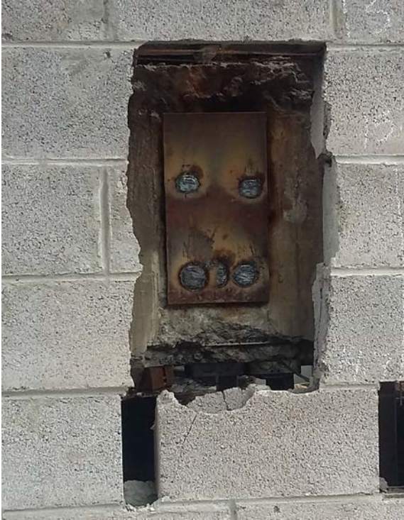
Imagen 7 y 8. Colocación de placas de acero sobre varillas expuestas
