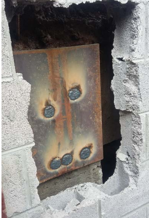
Imagen 7 y 8. Colocación de placas de acero sobre varillas expuestas
