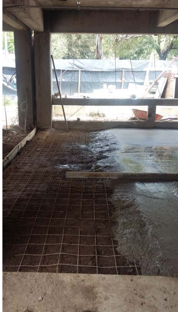
Imagen 5 y 6. Firmes y pisos de concreto reforzados con malla electrosoldada
