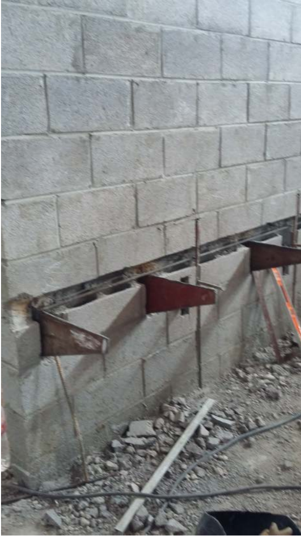
Imagen 11 y 12. Colocación de meseta para lavabos
