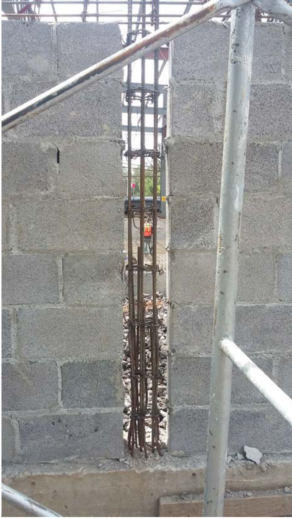
Imagen 3 y 4. Colocación de castillos
