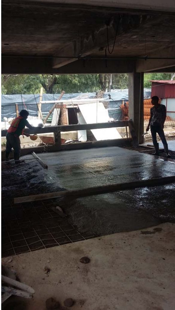
Imagen 5 y 6. Firmes y pisos de concreto reforzados con malla electrosoldada
