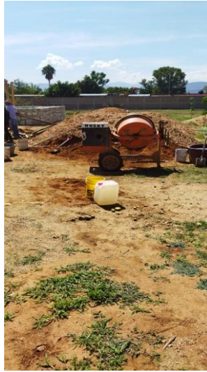
Imagen 12. Mezcla para levantamiento de muro (Autoría Propia, 2022).
