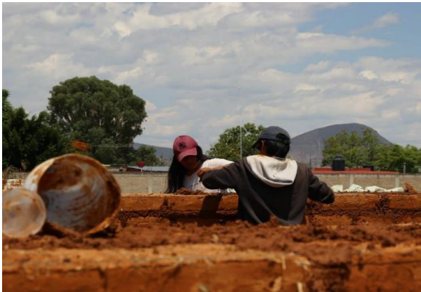
Imagen 14. Trabajo en muro de Adobe (Sánchez Jessica, 2022).
