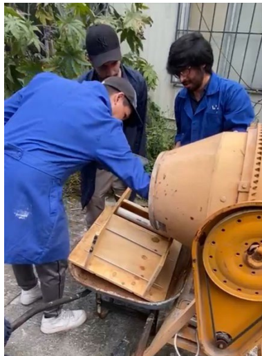
IMAGEN 2. Vaciado de concreto en moldes Fuente: Martínez, S
