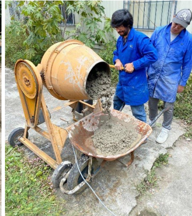
IMAGEN 6. Proceso para colado de moldes Fuente: Martínez, S.
