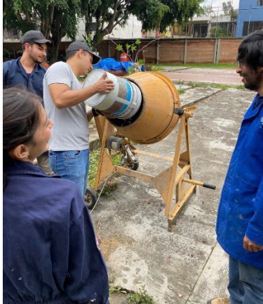
IMAGEN 4. Proceso para colado de moldes Fuente: Martínez, S.
