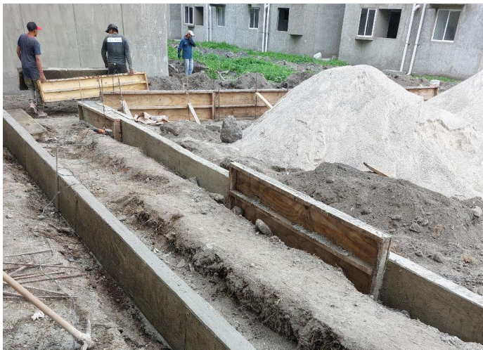
Figura 3.3 Descimbrado de las guarniciones en andadores.
