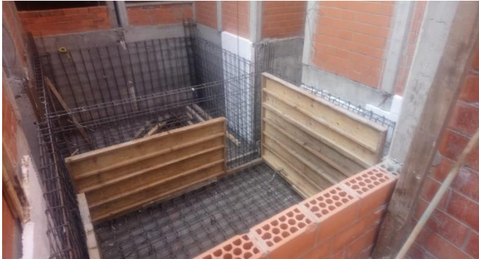
Figura 3.19 Inicio de cimbrado.
