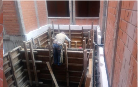
Figura 3.20 Troquelado de la cimbra en los muros de concreto.
