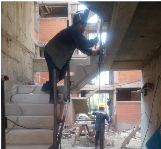
Figura 3.13 Colocación de postes para barandales de escaleras.
