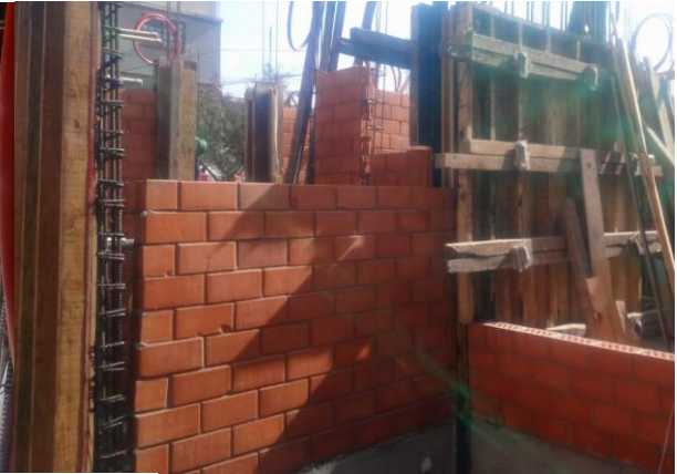
Figura 3.16 Cerramientos de la vivienda con ladrillo novaceramic y muros de concreto.
