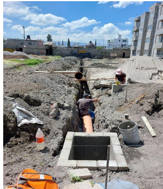
Figura 3.7 Colocación de la tubería de CPVC para drenaje.
