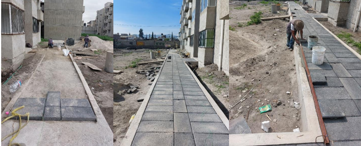
Figura 3.5 Proceso constructivo, desde la compactación de la cama de arena, pasando por la colocación del adocreto, finalizando con el junteado del mismo.
