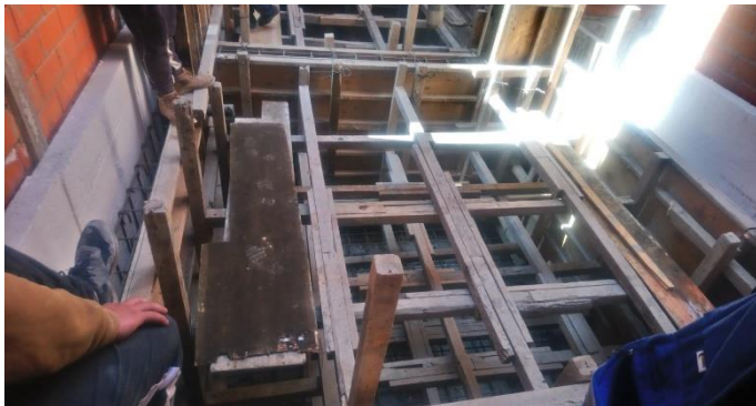
Figura 3.21 Preparaciones antes de iniciar colado.
