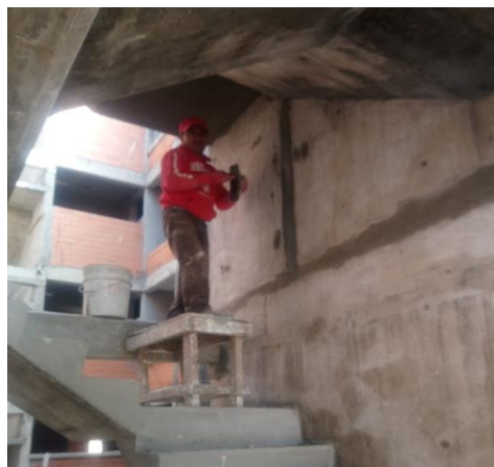
Figura 3.14 Aparentado de muros de carga para escaleras.
