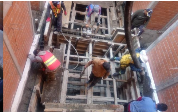
Figura 3.22 Colado de cisterna en progreso.
