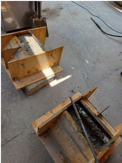
Fotografía 1: Colado de moldes de concreto (Amaya, 2024)
