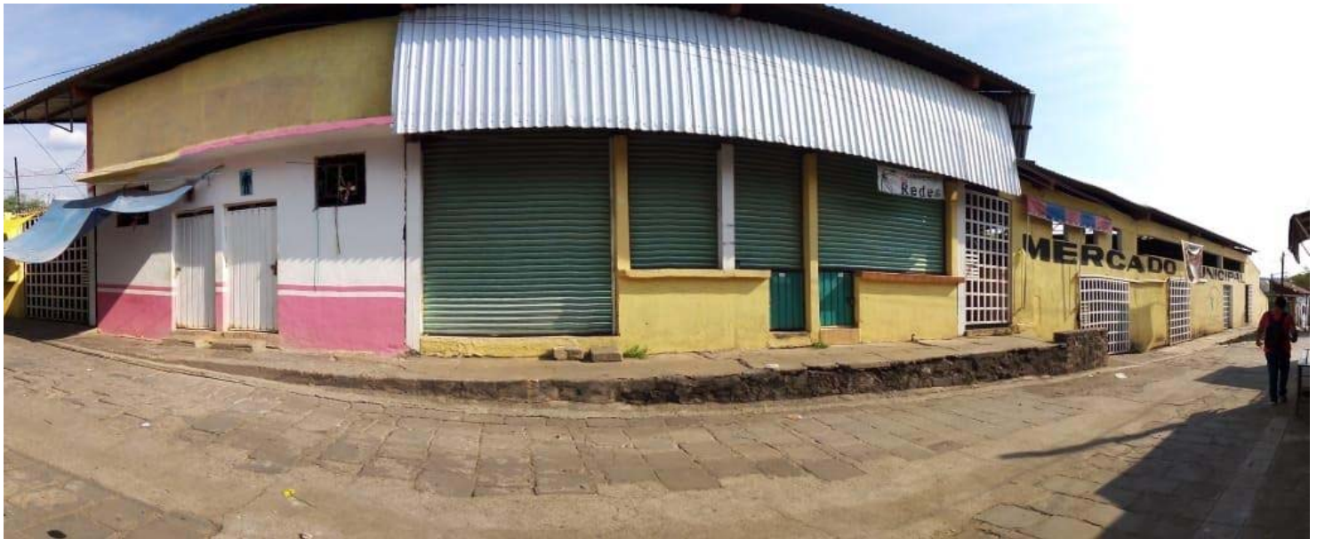
FACHADA LATERAL DEL MERCADO MUNICIPAL DE CUTZAMALA DE PINZON, GRO. ELABORACIÓN PROPIA
