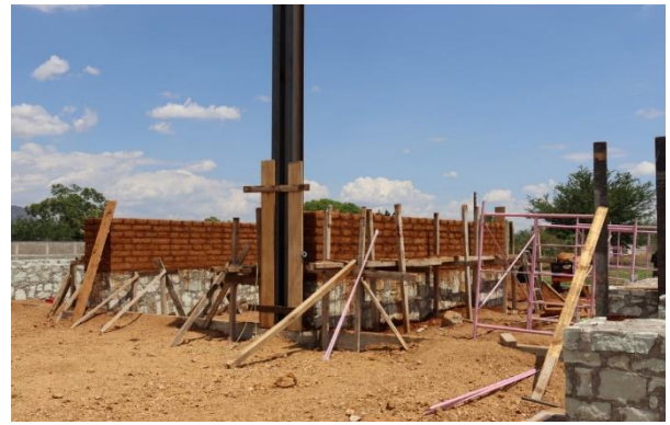
Levantamiento de muros con adobe en la capilla de La Raya Fotografía propia
