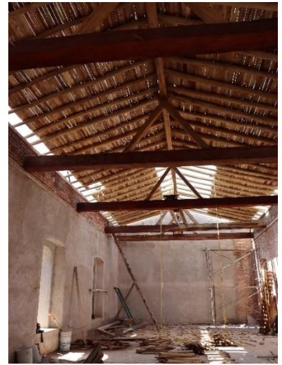
Obra en proceso en Juchitán de Zaragoza Fotografía propia
