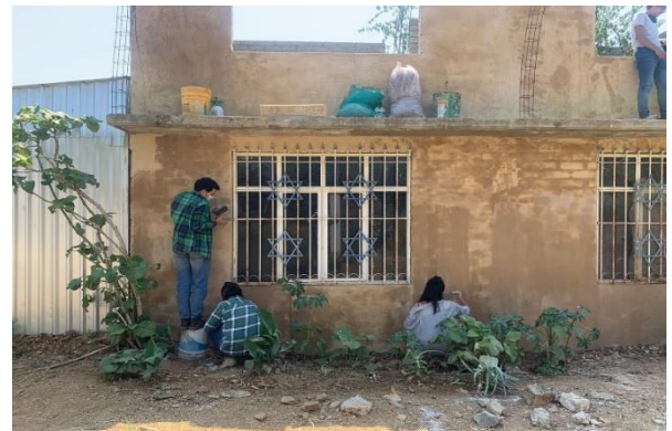
Colocación de pintura con tierra en la fachada Fotografía por Kenly
