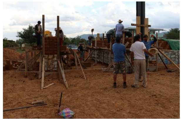
Levantamiento de muros con adobe en la capilla de La Raya Fotografía por Kenly
