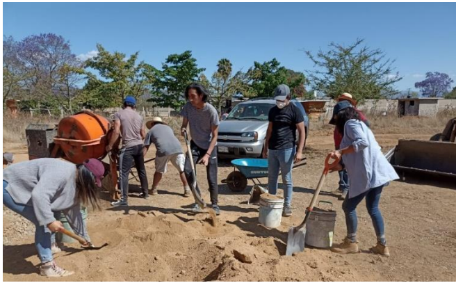
Proceso de elaboración de firme para depósito de PET Fotografía por Raquel Olivera
