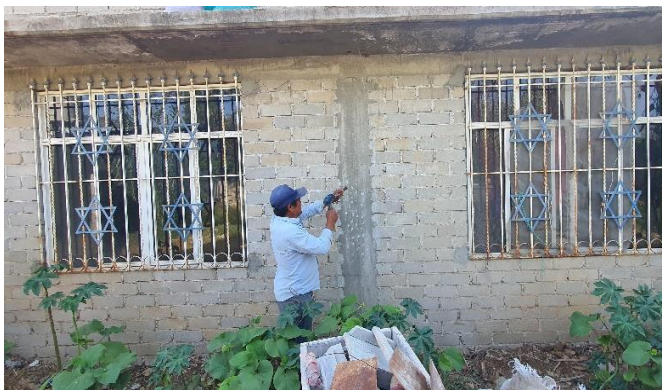
Preparación del muro para realizar el aplanado con tierra Fotografía propia
