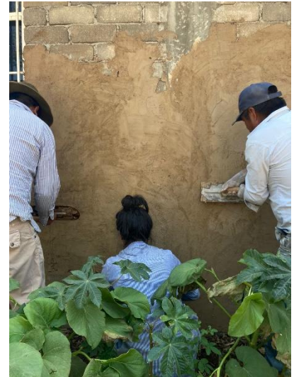
Proceso de aplanado con tierra en muros Fotografía por Kenlly
