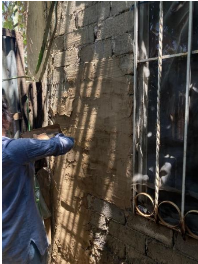
Proceso de aplanado con tierra en muros Fotografía por Kenlly
