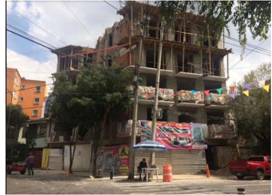
Fotografía 1.- Obra en Miravalle.
