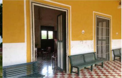
Fig. 41 Puertas y ventanas para propiciar la ventilación cruzada
