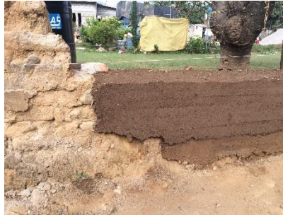
Fig.19. Comienzo de muro de tierra vertida en Totolapan
