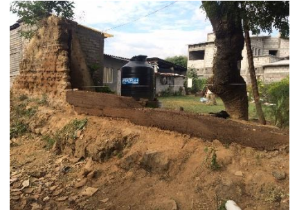
Fig.20. Avance de muro prototipo en Totolapan
