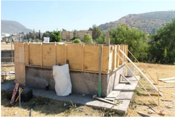
Fig.16. Construcción de módulo en CINVESTAV
