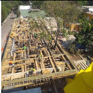
Comedor Cencalli, instalación de traves
