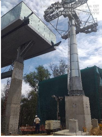
Cable bus estación de Constituyentes, supervisión de avances de obra.
