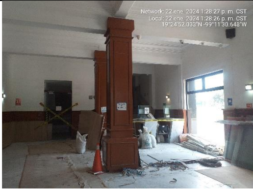
Desmontajes en edificio de fomento musical
