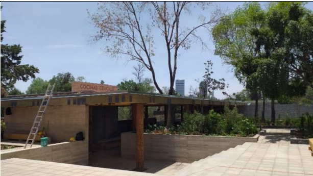
Comedor Cencalli, impermeabilización de techo.
