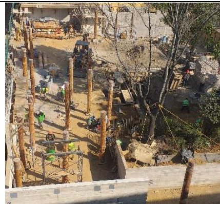
Construcción del comedor Cencalli. Levantamiento de columnas
