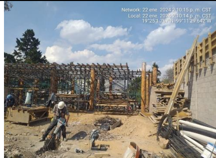
Comedor Cencalli, instalación de traves
