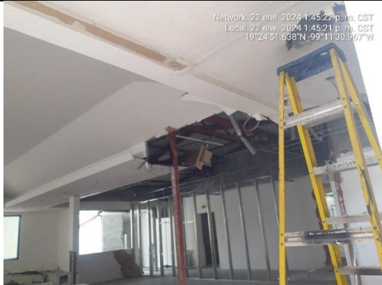
Desmontajes del edificio de fomento musical
