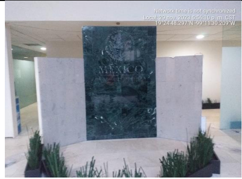
Desmontajes de edificio FONCA
