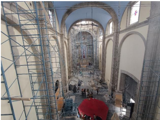
IMAGEN 03. Desmontaje de andamios en el Templo de La Santísima Trinidad. Fotografía por Jonathan Franco, octubre 2024.
