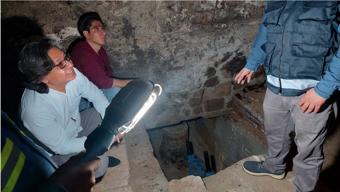
IMAGEN 10. Revisión de las condiciones de los pilotes del Templo de San Juan de Dios junto con el equipo de la empresa experta. Fotografía por el equipo del Fideicomiso, enero 2025.
