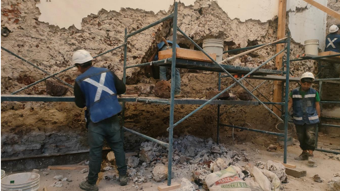
IMAGEN 08. Intervención de daños en muros de la pinacoteca del Templo de la Rectoría de San Felipe Neri, La Profesa. Fotografía por el equipo del Fideicomiso, septiembre 2024.
