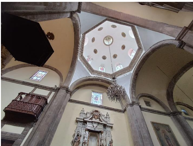
IMAGEN 12. Bóveda, pechinas y muros restaurados del Templo de San Juan de Dios. Fotografía por Jonathan Franco, enero 2025.
