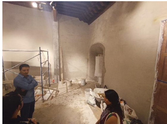
IMAGEN 04. Recorrido de trabajos de obra en el Templo de la Rectoría de San Felipe Neri, La Profesa. Fotografía por Jonathan Franco, noviembre 2024.
