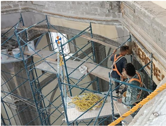
IMAGEN 01. Limpieza de letros en interior de cúpula del Templo de La Santísima Trinidad. Fotografía por Jonathan Franco, octubre 2024.
