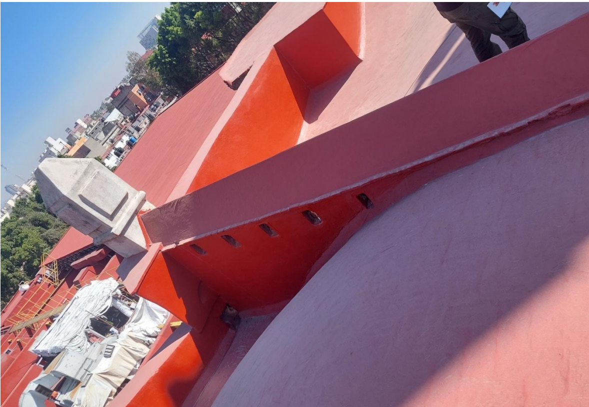
IMAGEN 15. Impermeabilización de las bóvedas del Templo de San Juan de Dios. Fotografía por Jonathan Franco, enero 2025.
