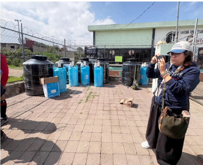
DESCARGA DE MATERIAL
