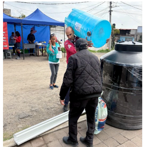
DESCARGA DE MATERIAL
