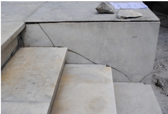
Imagen 6. Rupturas parciales en mármol
