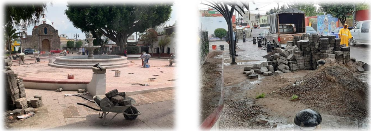
Imagen 3 y 4 sustitución de piezas dañadas de cantera alrededor de la fuente y cambio de adoquín en calle de Dalia.
