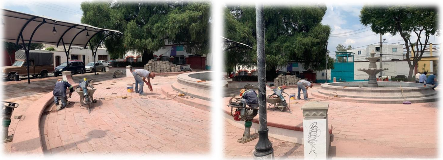
Imagen 1 y 2 trabajos de remodelación Plazuela barrio San Cristóbal.
