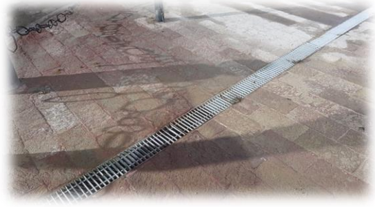
Imagen 5 y 6 creación de bahía peatonal para mejoramiento de acceso a la plazuela y rejillas de captación pluvial dirigida a los canales cercanos.
