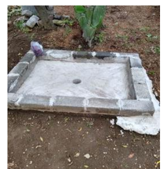
Imagen 17. Área de preparación de mezclas
