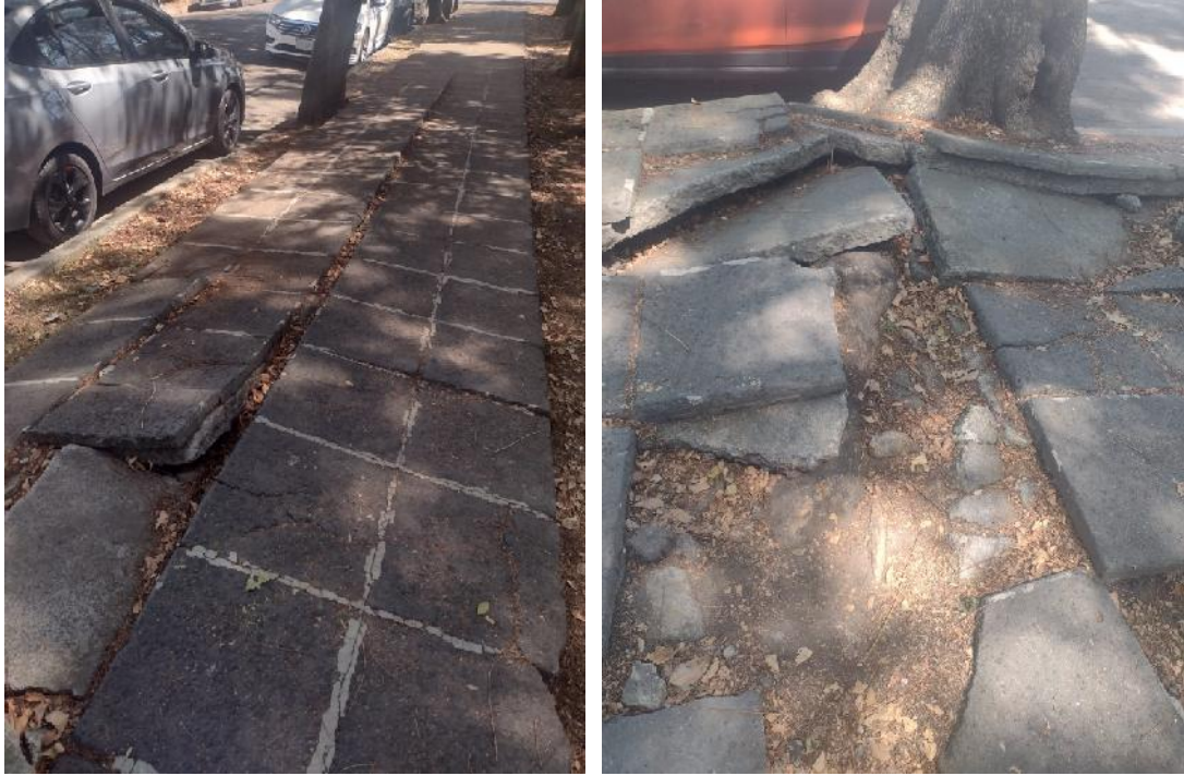
Imagen 24. Ruptura en banqueta por raíces de los árboles.
