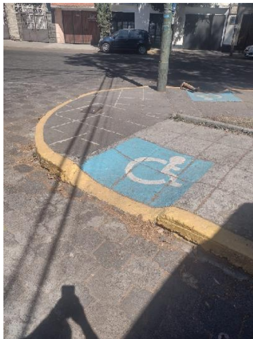
Imagen 19. Rampa doble para personas con discapacidades diferentes. Fuente: Fotografía propia, febrero 2024.
