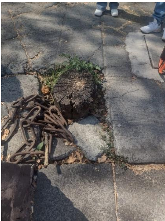
Imagen 21. Retiro de tocón de 1.00 y 1.50 m de diámetro. Fuente: Fotografía propia, febrero 2024.
