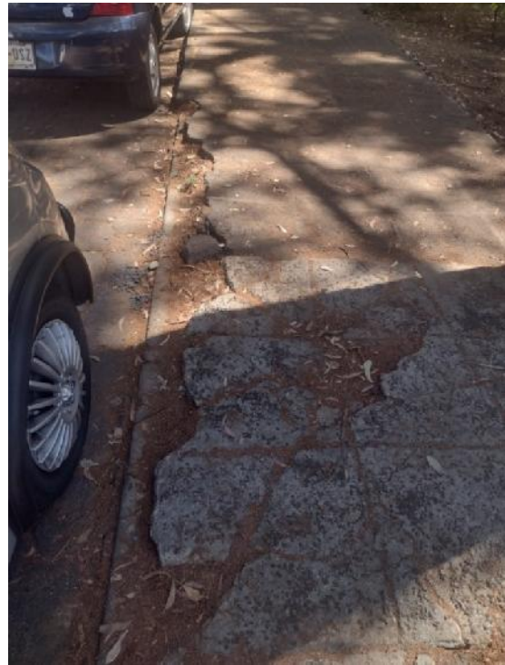
Imagen 20. Deterioro de guarnición y banqueta. Fuente: Fotografía propia, febrero 2024.
