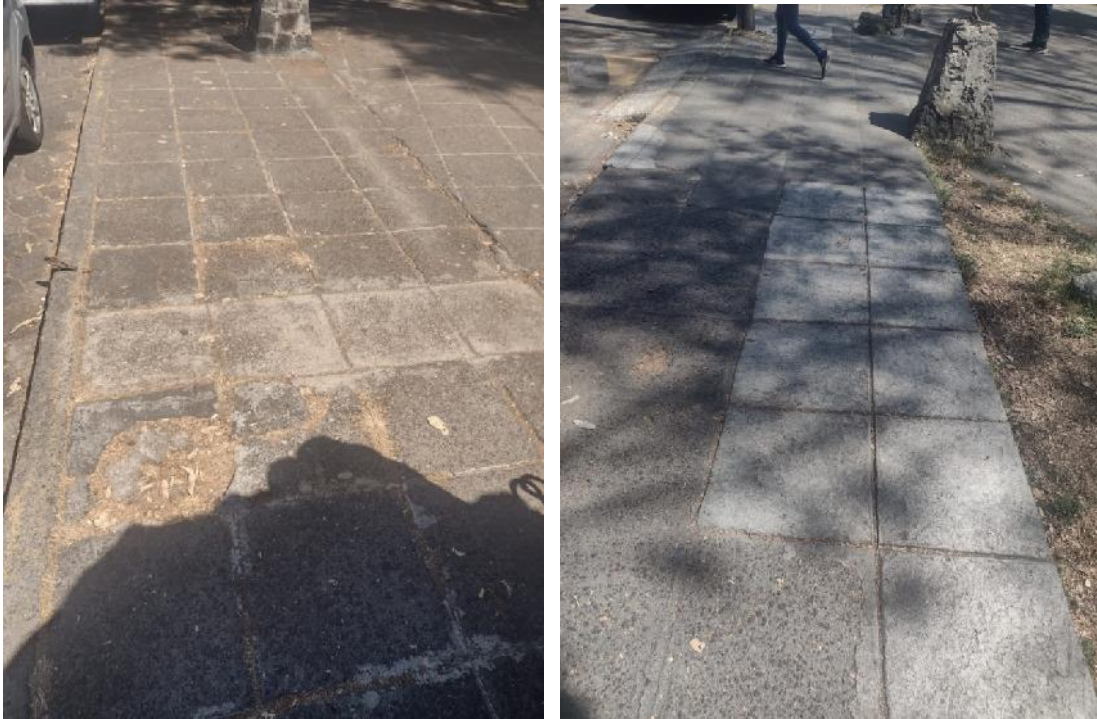
Imagen 26. Reparación de banqueta de piedra con concreto. Fuente: Fotografía propia, febrero 2024.
