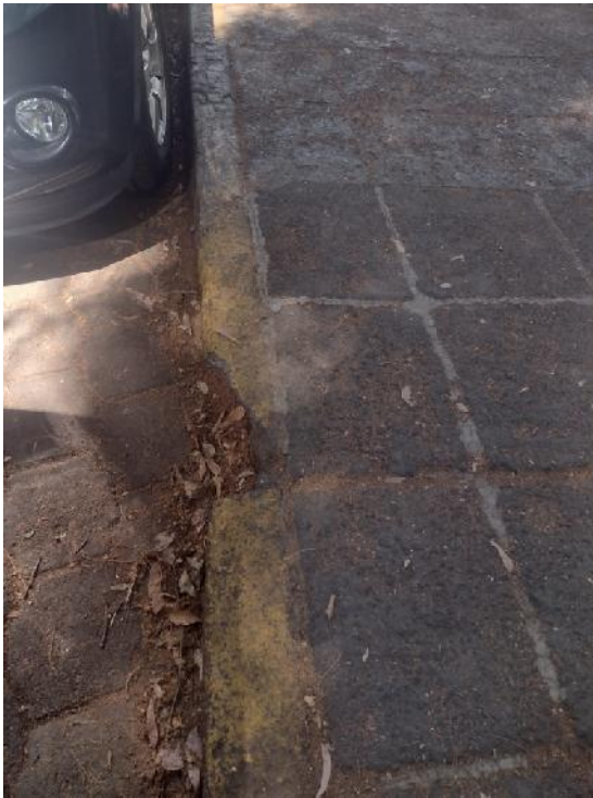
Imagen 20. Deterioro de guarnición y banqueta. Fuente: Fotografía propia, febrero 2024.
