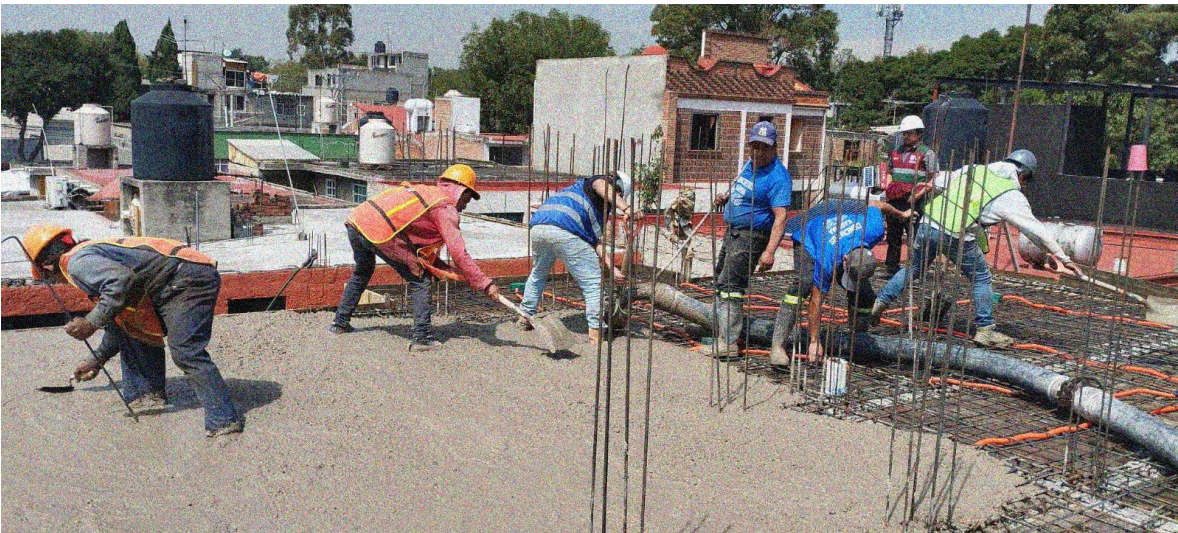
Fig. 30: Visita de obra y supervisión - acreditado Humberto Pérez (Fuente propia).
