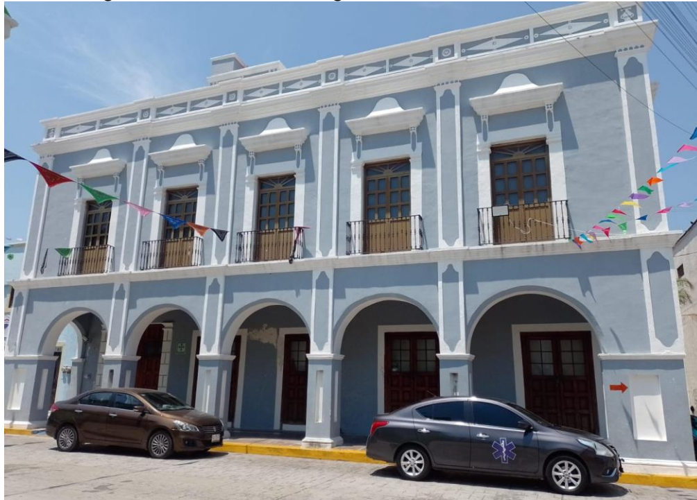
Imagen 9 Edificio de la antigua aduana en Cd. del Carmen
