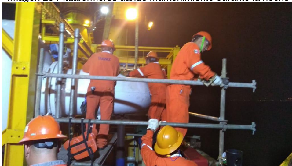
Imagen 25 Plataformeros dando mantenimiento durante la noche
