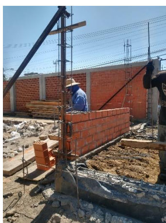
17. Edith Martínez, año 2023, Fotografía de habilitado de muro en zona de depósito, obra Tlaxilacalli
