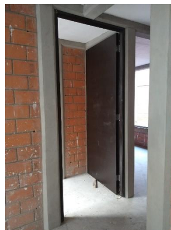
12. Edith Martínez, año 2023, Fotografía de Colocación de puerta de madera, obra MZ 25
