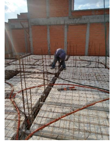
4. Edith Martínez, año 2023, Fotografía de habilitado de acero para losa de entresuelo de la última torre, obra MZ 25
