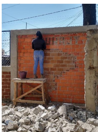
21. Edith Martínez, año 2023, Fotografía de limpieza de muros en barda perimetral, obra Tlaxilacalli
