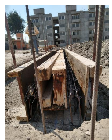
15. Edith Martínez, año 2023, Fotografía de cimbrado y habilitado de acero para rejilla del área de estacionamiento, obra Tlaxilacalli
