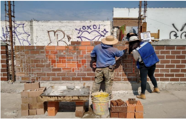
9. Edith Martínez, año 2023, Fotografía de Levantamiento de muro de barda perimetral (mural che Guevara), obra Tlaxilacalli
