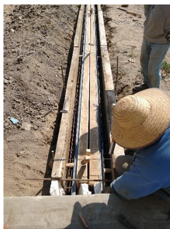
6. Edith Martínez, año 2023, Fotografía de cimbrado de rejilla en el área de estacionamiento, obra Tlaxilacalli
