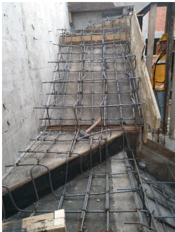
26. Edith Martínez, año 2023, Fotografía de cimbrado y habilitado de acero para escalera de la ultima torre, obra MZ 25
