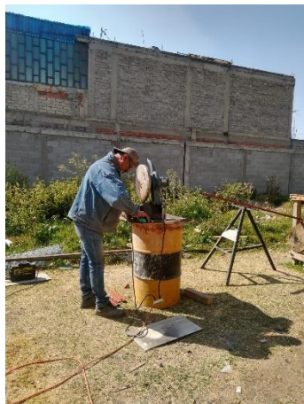
25. Edith Martínez, año 2023, Fotografía de armado de acero para ventanas de la caseta de vigilancia, obra MZ 25
