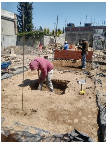
18. Edith Martínez, año 2023, Fotografía de excavación para registros, obra Tlaxilacalli
