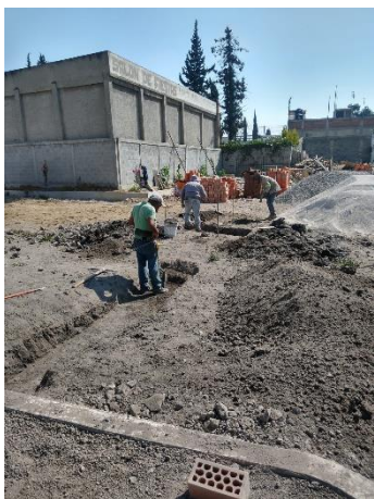
22. Edith Martínez, año 2023, Fotografía excavación de sepas para registro general, obra Tlaxilacalli
