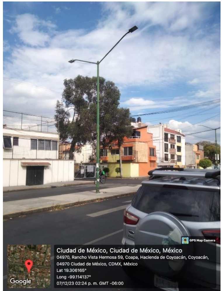
Imagen 11. _ Localización de la luminaria
