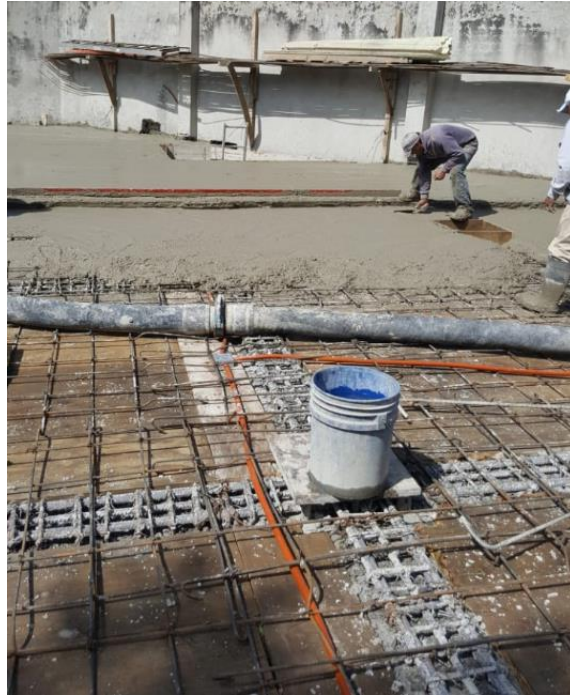
Supervisión de obra y colado de losa
