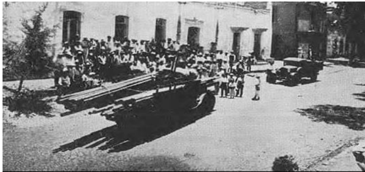
Llegada de la primera remesa de materiales a Milpa Alta para la construcción del acueducto de Monte Alegre, julio de 1933
