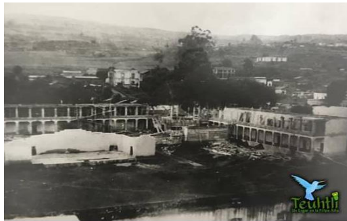
Construcción del Centro Escolar José María Morelos (1941-43). Milpa Alta, CDMX.
