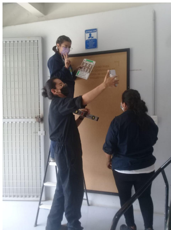
Colocación de tableros
