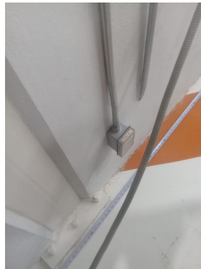
Medición de tomas eléctricas
