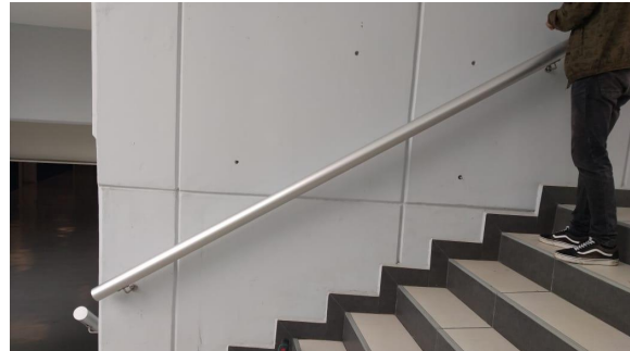
Reinstalación de barandal
