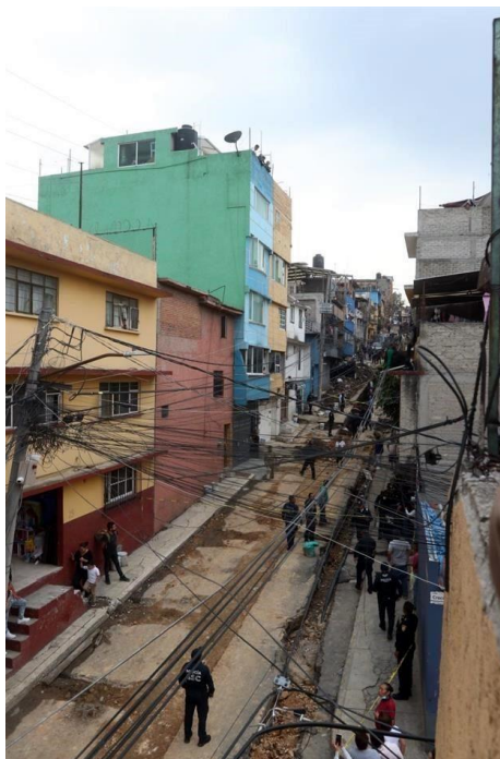
Imagen 11. Derrumbe en Olivar del Conde
