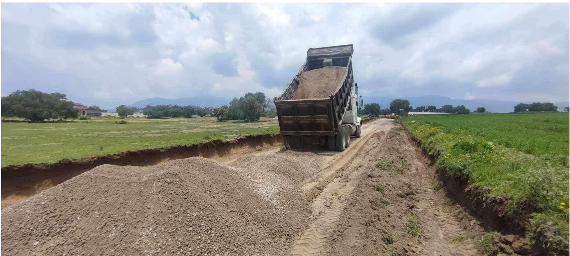
Ilustración 4,5 y 6: Visita de obra a caminos de terracería
