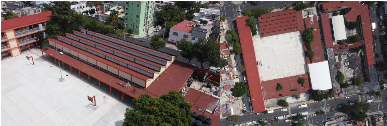
Imagen III: Foto área del edificio de talleres.
