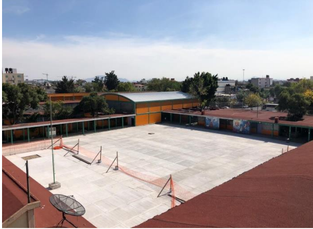
Imagen X: Foto del patio desde la azotea.
