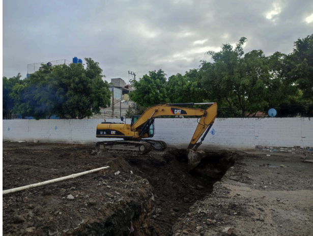
Imagen 1.2 excavación de 2 metros de profundidad para la cimentación del edificio, 28 de octubre del 2023 (autoría propia).
