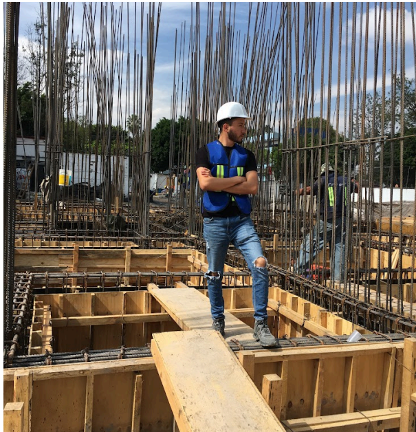
Imagen 1.3 colocación de armado y cimbra de uno de los 5 cajones de cimentación, 29 de noviembre del 2023 (autoría propia).
