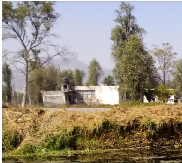
Fotografía 41. Identificación de una vivienda en la zona chinampera en la actualidad. A diferencia de 1940 y 1972, ahora las viviendas son mucho más grandes. Varias ya cuentan con dos niveles. Fuente: Propia, 2021.
