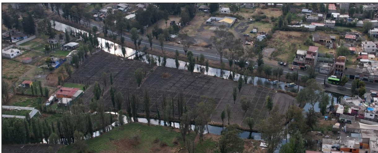
Fotografía 9. Vuelo aéreo sobre los canales de la zona chinampera de San Miguel para reconocer las superficies de agua libres de lirio acuático o vegetación diversa. Fuente: Propia, 2022.
