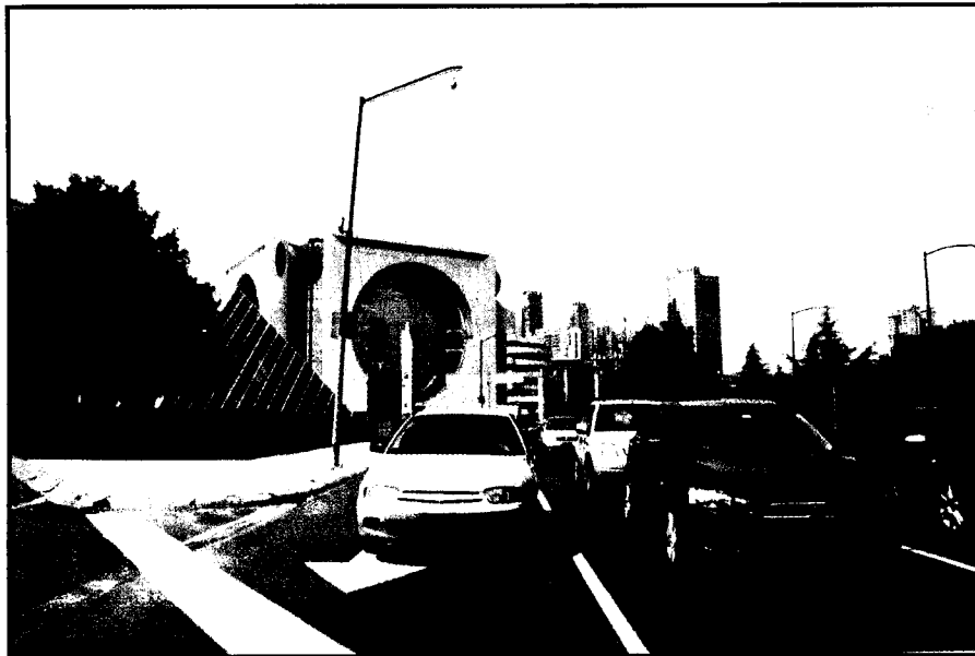
Ilustración 15. Foto del edificio Calakmul ubicado al frente de Puerta Santa Fe.
