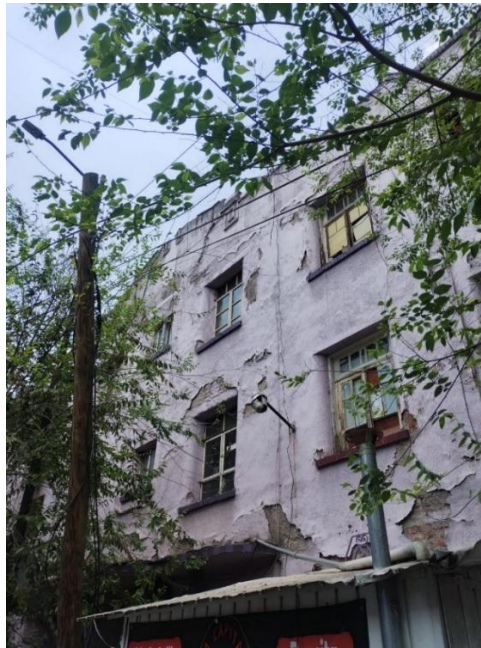
Figura 5. Estado de conservación de la fachada exterior.
