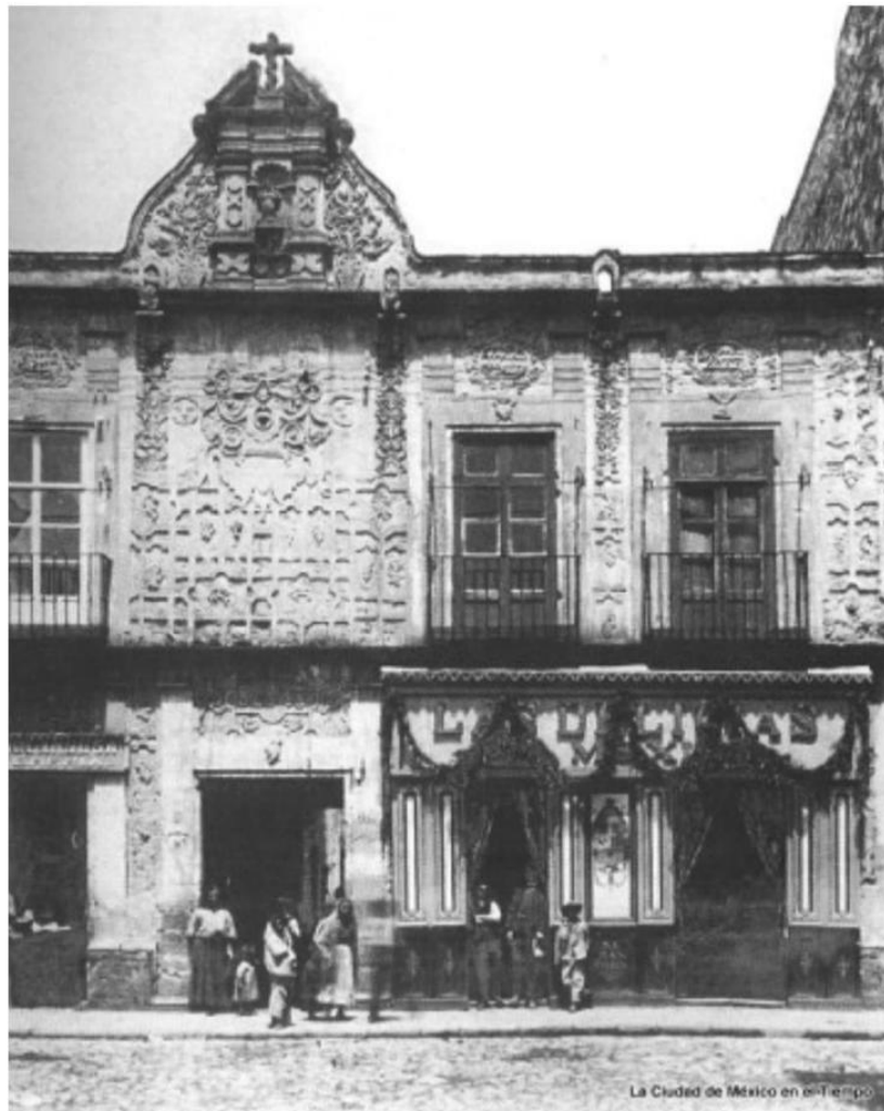
Figura 2. Vista histórica de la fachada de la pulquería y fonda “Las Delicias de México”.
