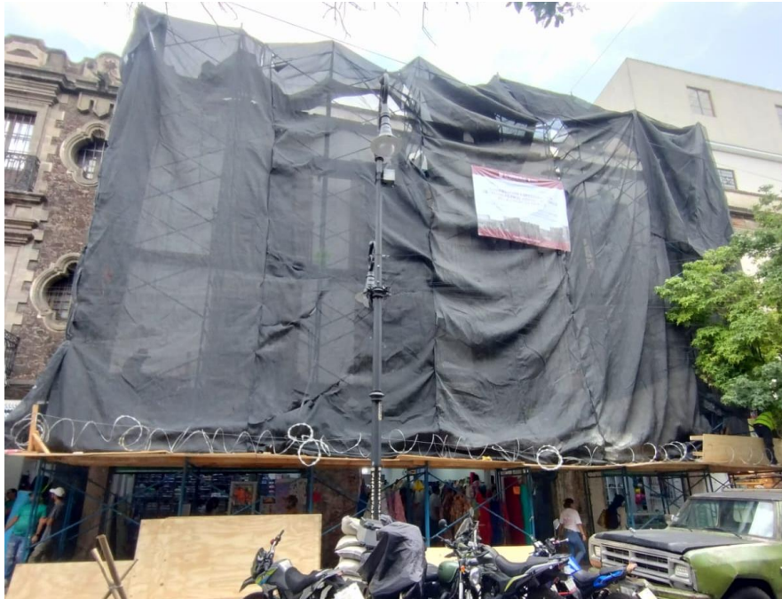
Figura 9. Montaje de andamiaje y cubierta de protección en la fachada.
