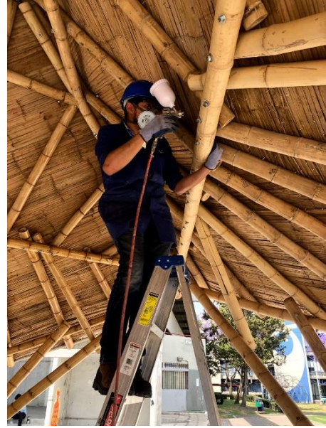
5 Aplicación de nitrocelulosa sobre estructura de bambú
