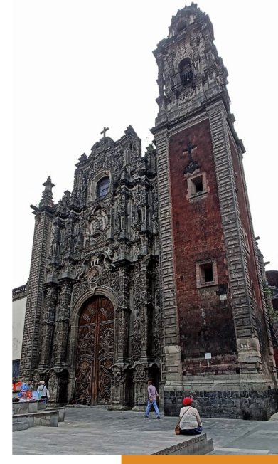
Imagen 5. Santísima Trinidad, Fachada Principal, Foto: GLR, Marzo 2023
