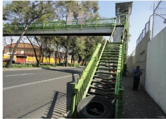
Puente Peatonal Ermita-Cuitlahuac
