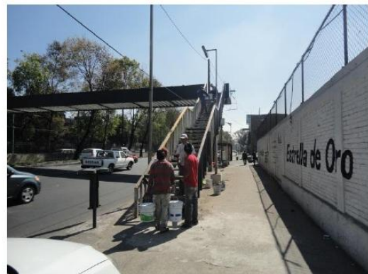
Puente Peatonal Calzada de Tlalpan y Circunvalación
