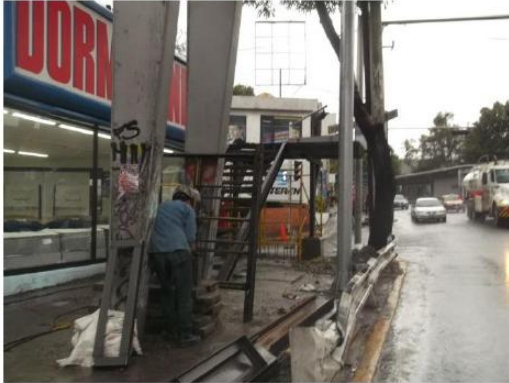
Puente peatonal Insurgentes Sur y Sta. Ursula
