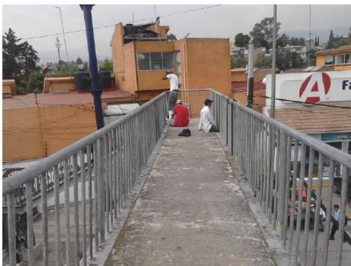
Puente Peatonal Insurgentes Sur-Mayas
