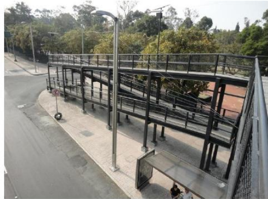
Puente Peatonal Constituyentes
