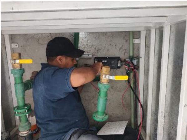
Instalación de bomba hidráulica.
