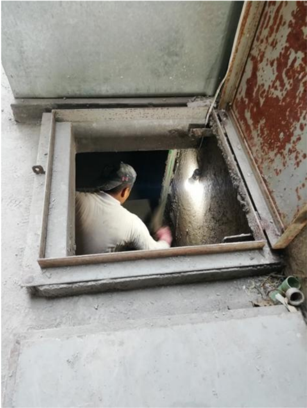
Aplanado instalación de tubería hidráulica en cisternas.
