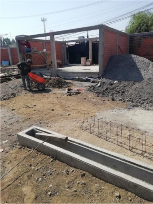
Elaboración de canaletas y registros para desagüe en área de estacionamiento.
