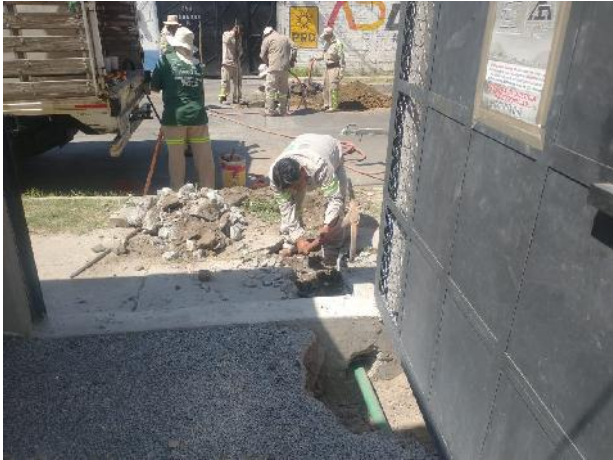
Conexión de toma de agua
