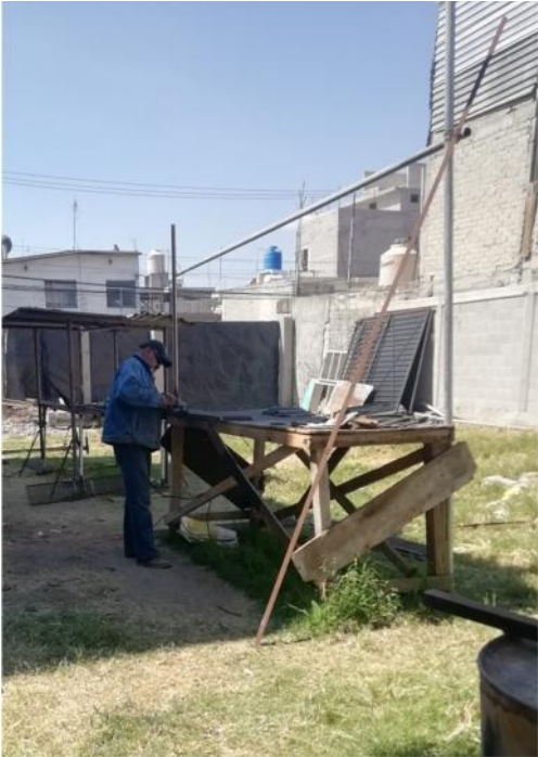
Elaboración de canaletas y registros para desagüe en área de estacionamiento.
