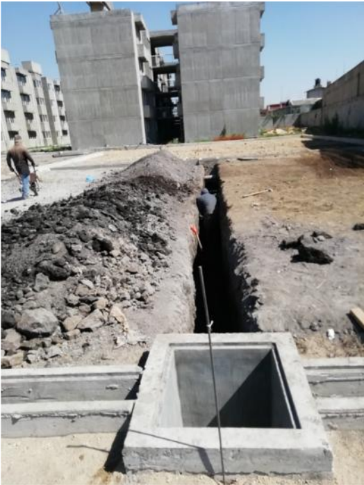
Instalación de tubería para red de drenaje general.
