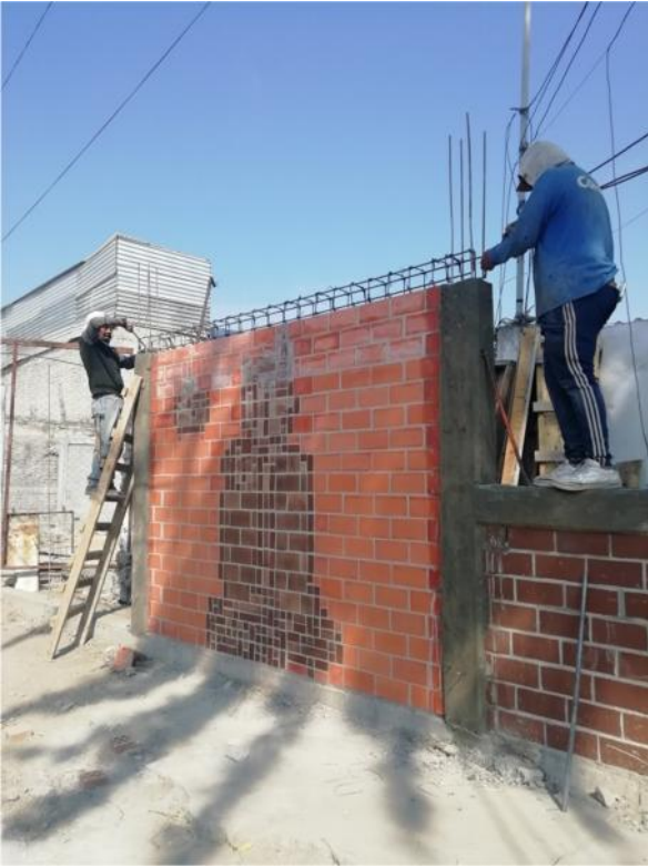
Construcción de murales en fachada principal.
