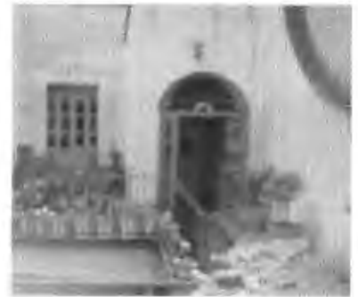
Anexo 15. Final de la restauración
