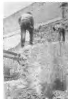
Anexo 3. Material descubierto al retirar el aplanado sistema de reforzamiento pared oeste
