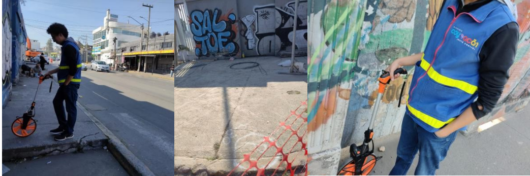
Fuente: Levantamiento en circuito azteca para la instalación de postes de la nueva línea 14 del Trolebús. Imagen, propia: Itzel Berenice Flores Vega.
