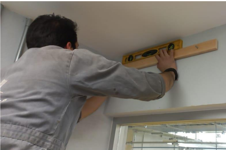
Montaje nivelado de gabinetes.
