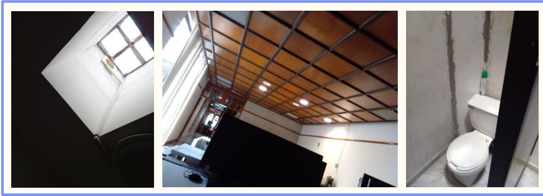
Figura 3. Fotos de inspección de iluminación y ventilación natural, así como niveles de humedad.
