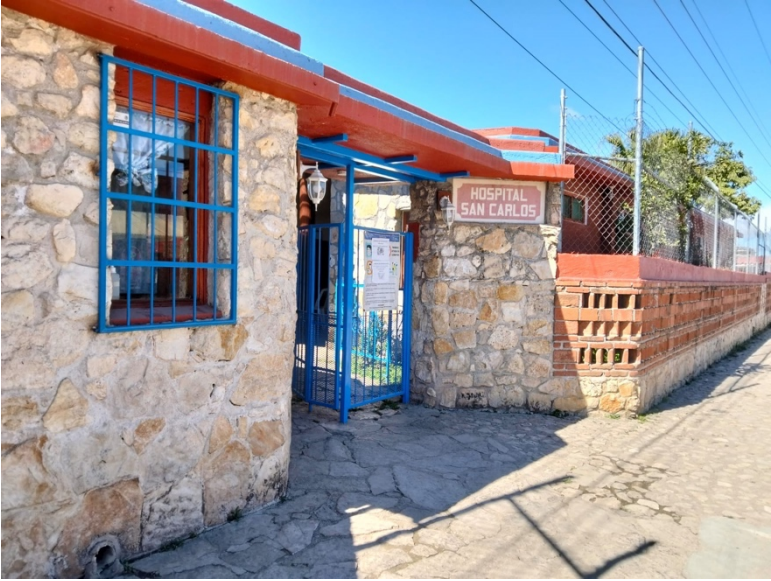
Imagen de la entrada al Hospital San Carlos. (Fuente: MPSS Pineda, 2024).
