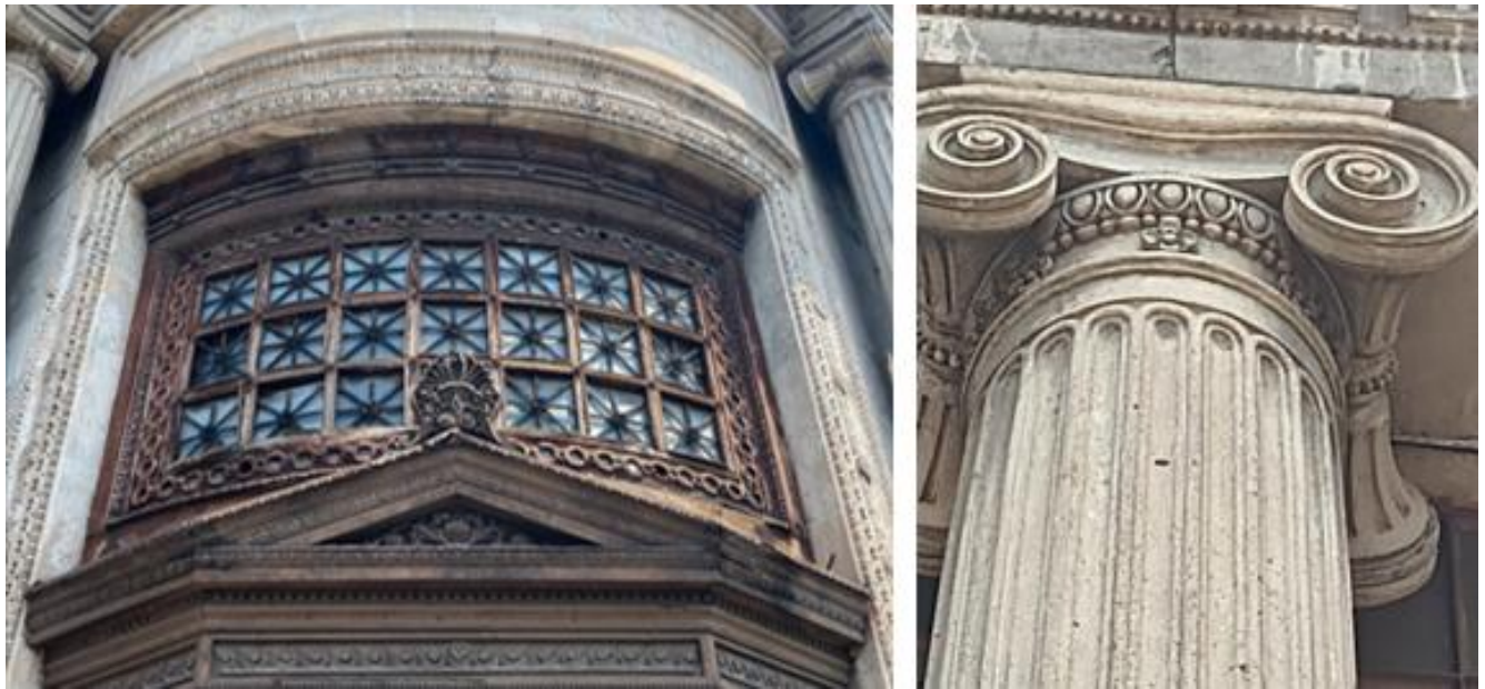
Detalles de las columnas en la fachada. (Fotografías propias, 2022)
