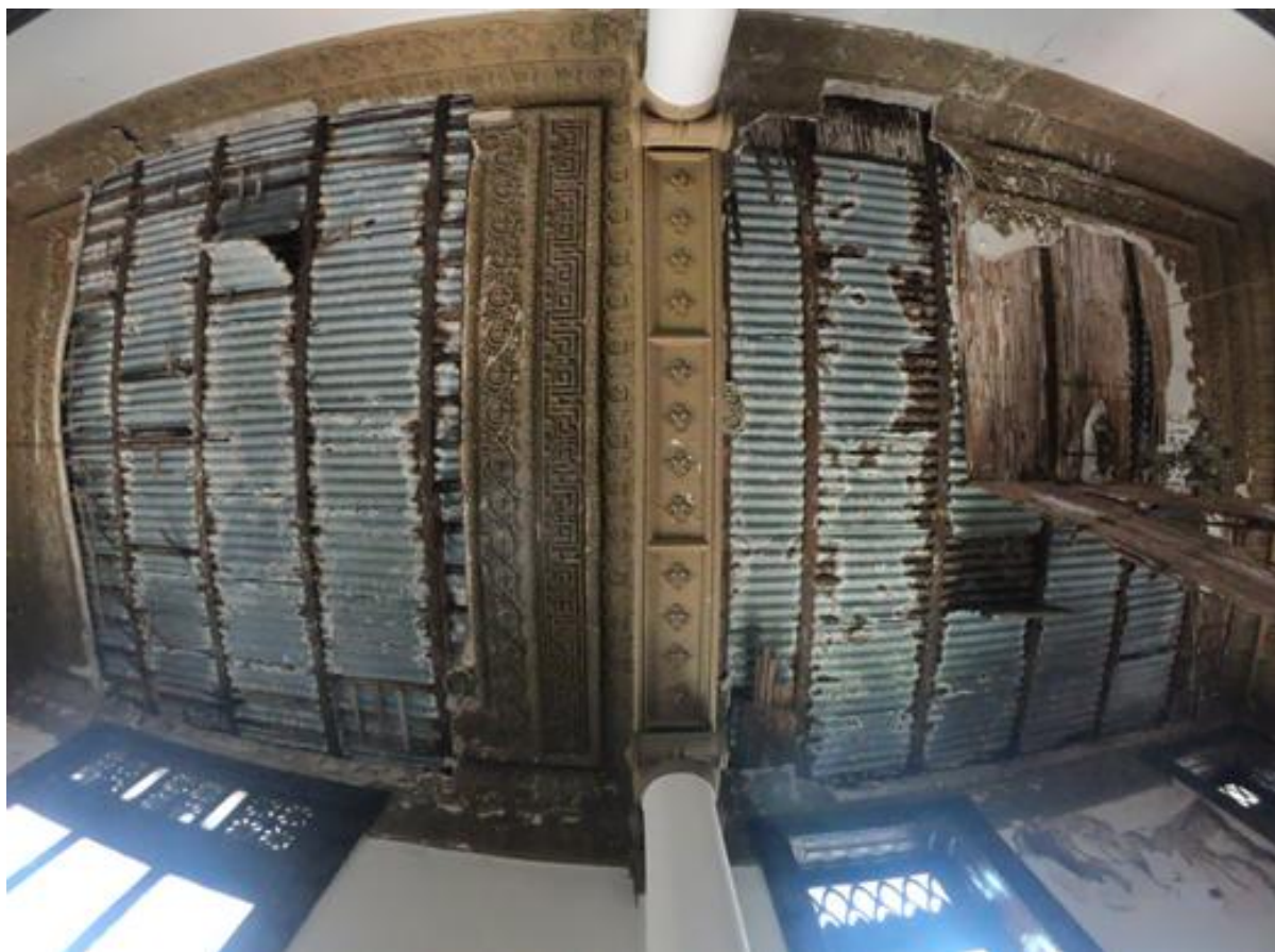
Vista de techumbre en local de primer nivel. (Fotografía propia, 2022)
