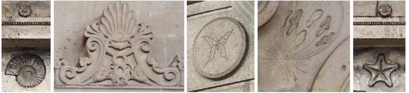
Detalles en la cantera del edificio. (Fotografías propias, 2022)
