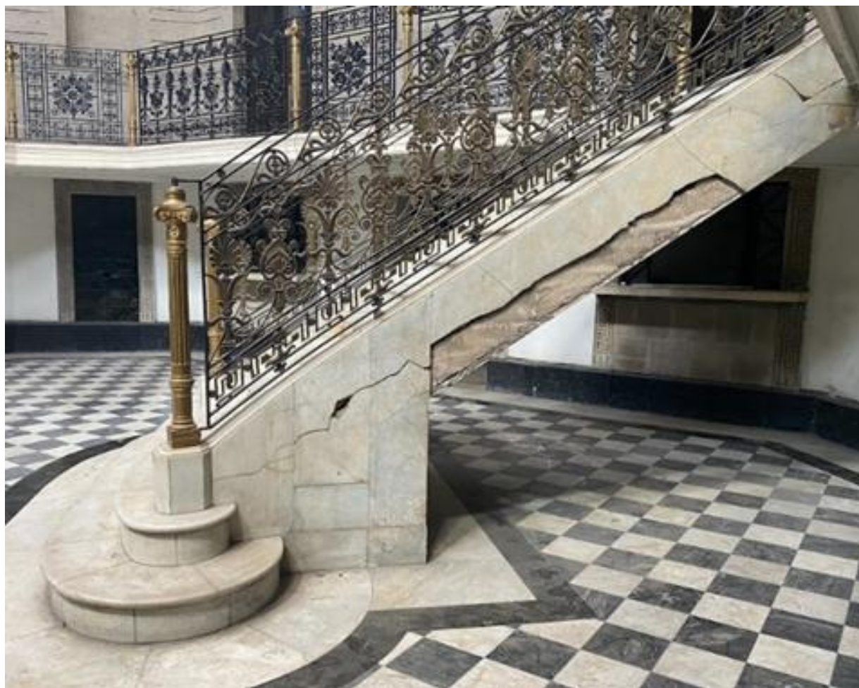
Escalera de patio central. (Fotografía propia, 2022)
