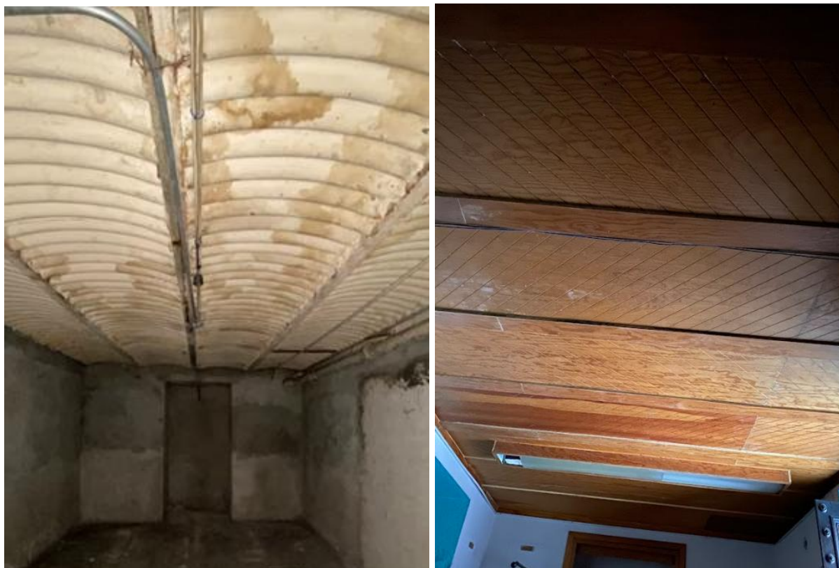
Acabados en plafones de planta baja. (Fotografías propias, 2022)
