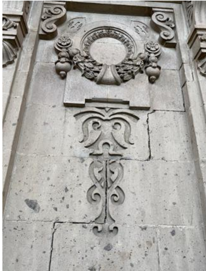
Detalle en fachada interior. (Fotografía propia, 2022)
