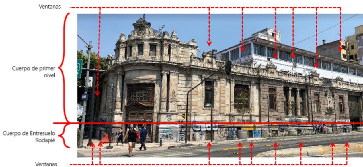
Fachada sobre Avenida Balderas. (Fotografía propia, 2022)
