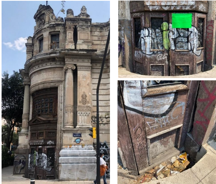
Puerta de acceso principal en Balderas y Ayuntamiento (Fotografías propias, 2022)
