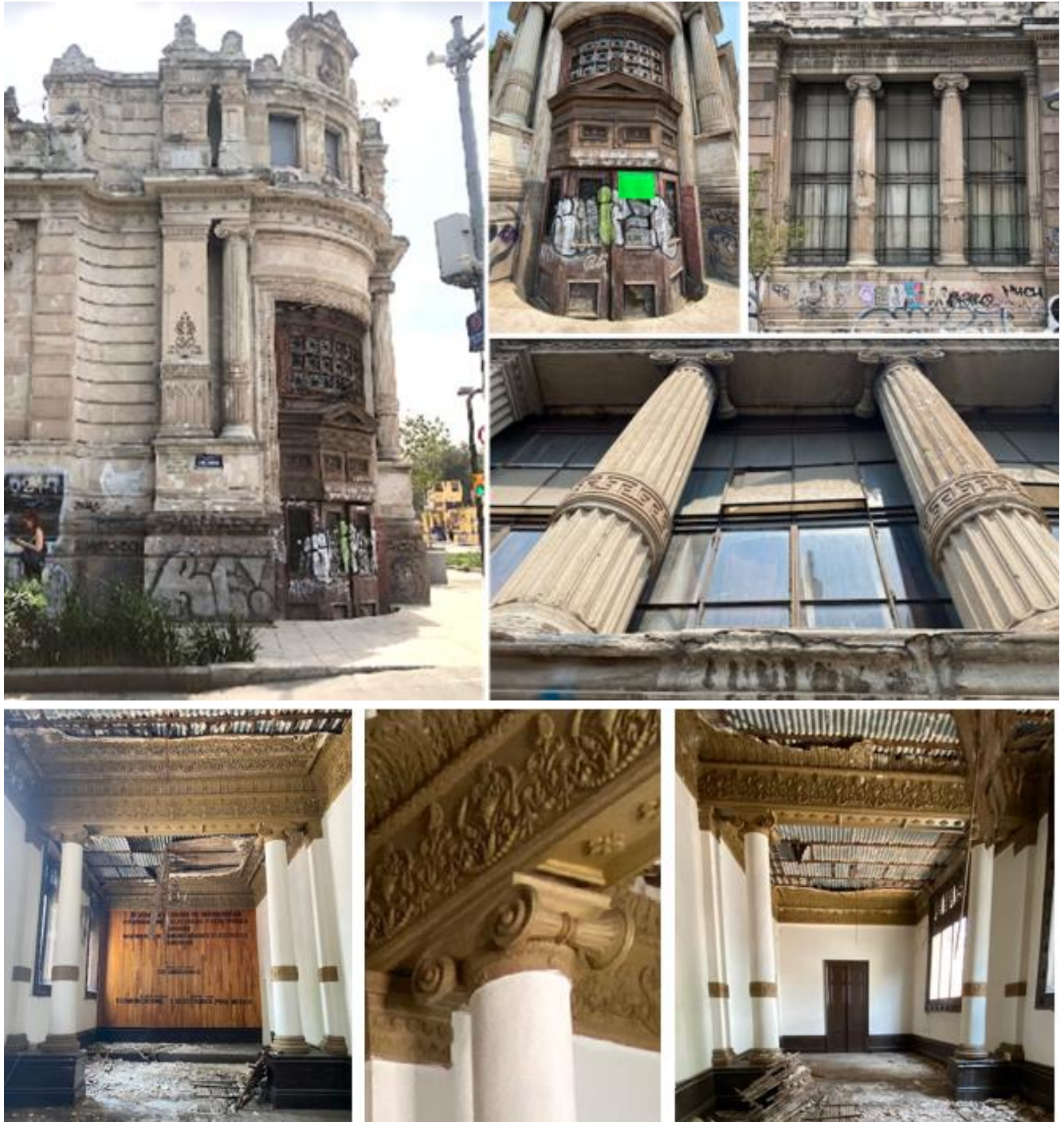
Detalles de las columnas en las fachadas. (Fotografías propias, 2022)
