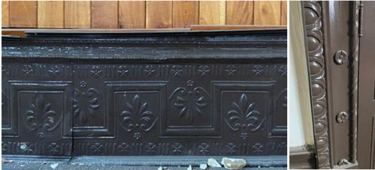
Detalles de carpintería (Fotografías propias, 2022)
