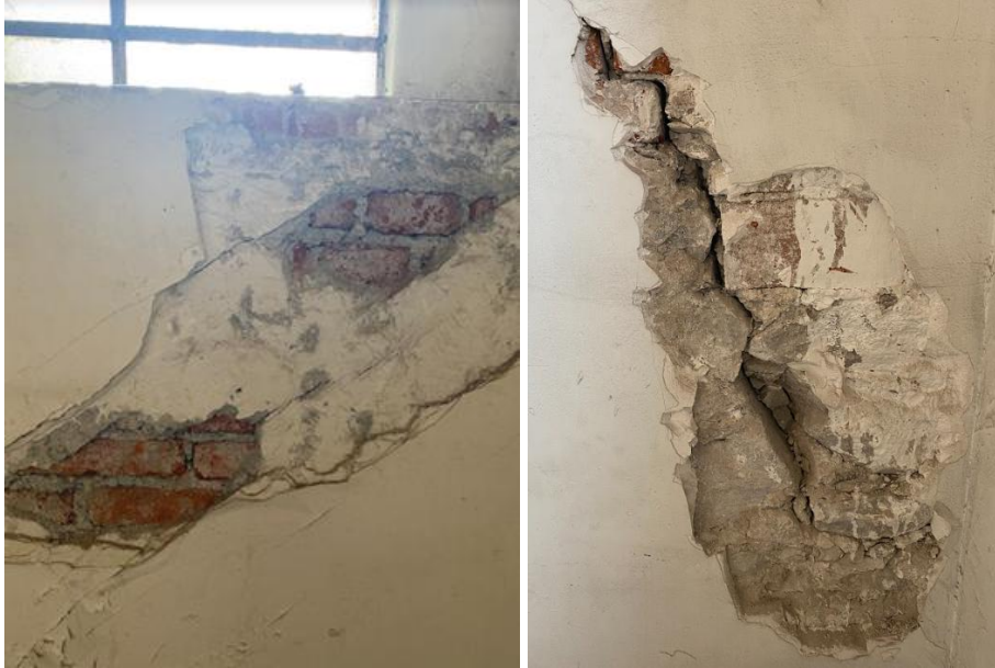
Muros. (Fotografías propias, 2022)
