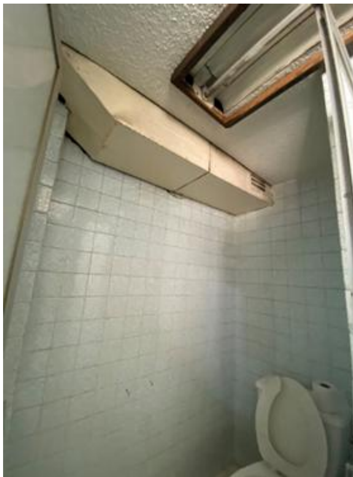
Sanitario de planta baja. (Fotografía propia, 2022)
