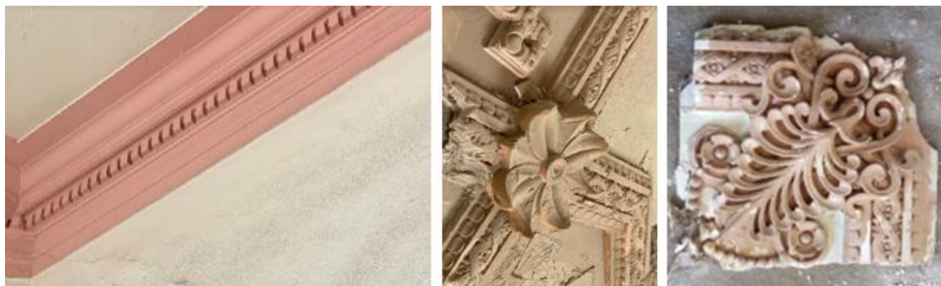
Detalles de ornamentación en cornisas y plafones de los, locales de primer nivel. (Fotografías propias, 2022)
