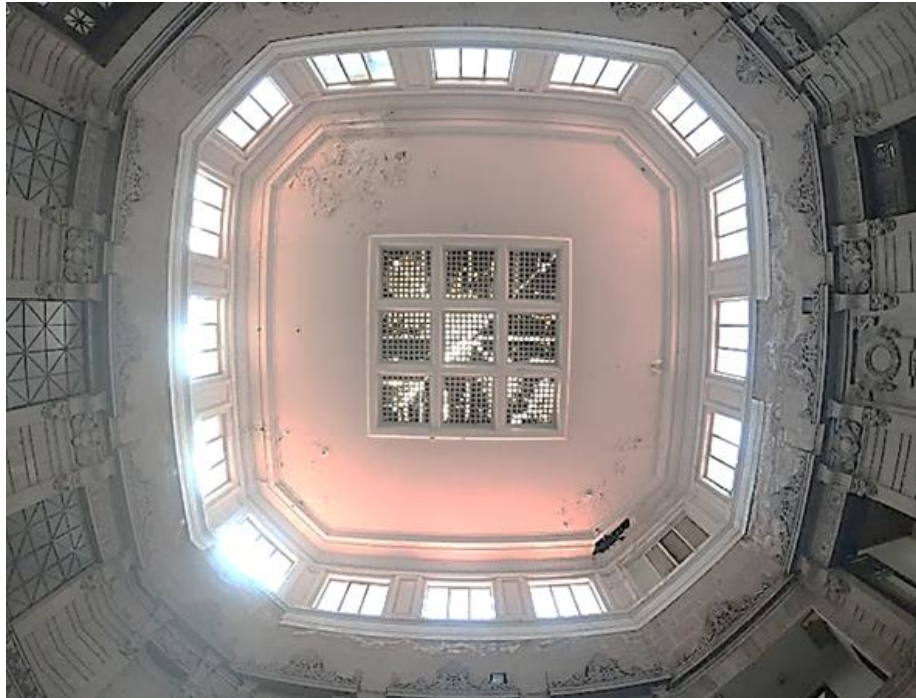
Cubierta del patio vista desde el interior. (Martínez, Édgar, 2022)
