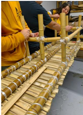
Imagen 3: Armado y amarre de bambú, para materialización de mobiliario urbano. Autor: Maximiliano Guzmán
